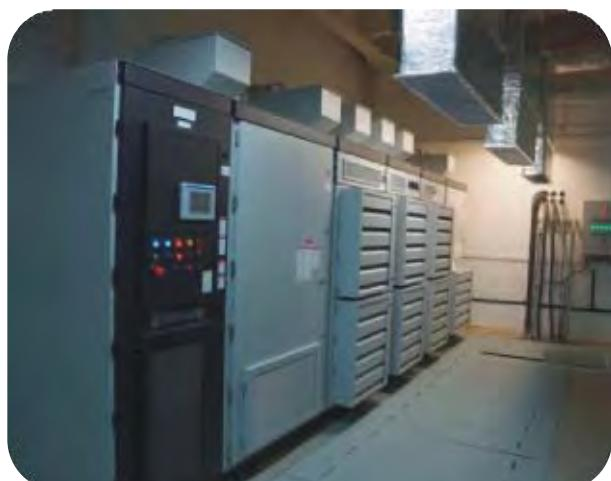
В комплектацию частотного преобразователя PowerFlex7000 с воздушным охлаждением компании Rockwell Automation входят следующие шкафы:
