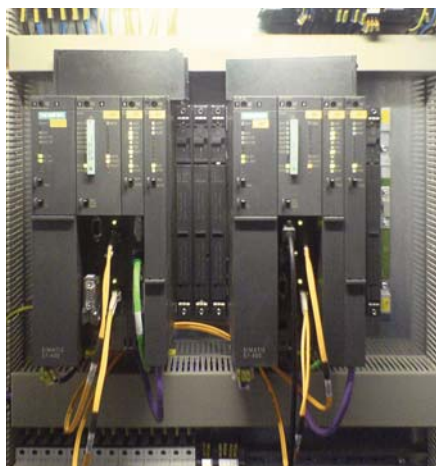
Рис. 4. Дублированный контроллер S7-400
