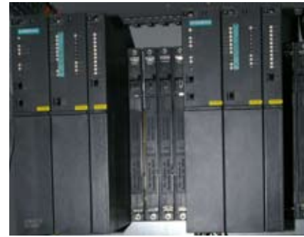
Рис. 8. Управляющий программируемый логический контроллер системы
