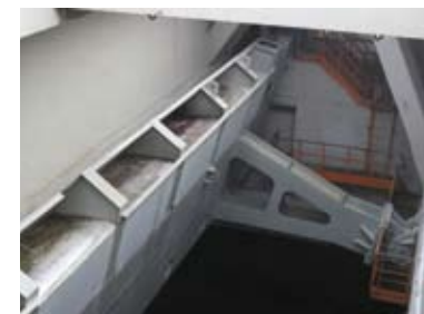
Рис. 2. Сегментный затвор
