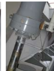
Рис. 3. Гидроцилиндр для подъема сегментного затвора
