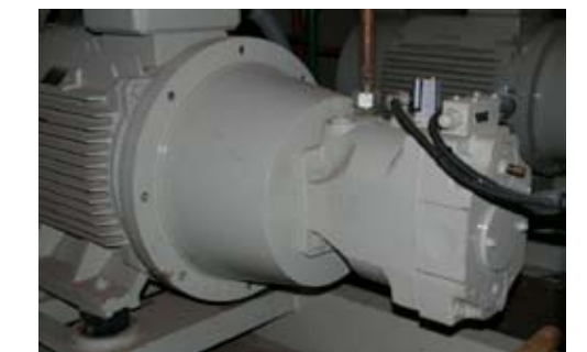
Рис. 5. Агрегат маслонапорной установки
