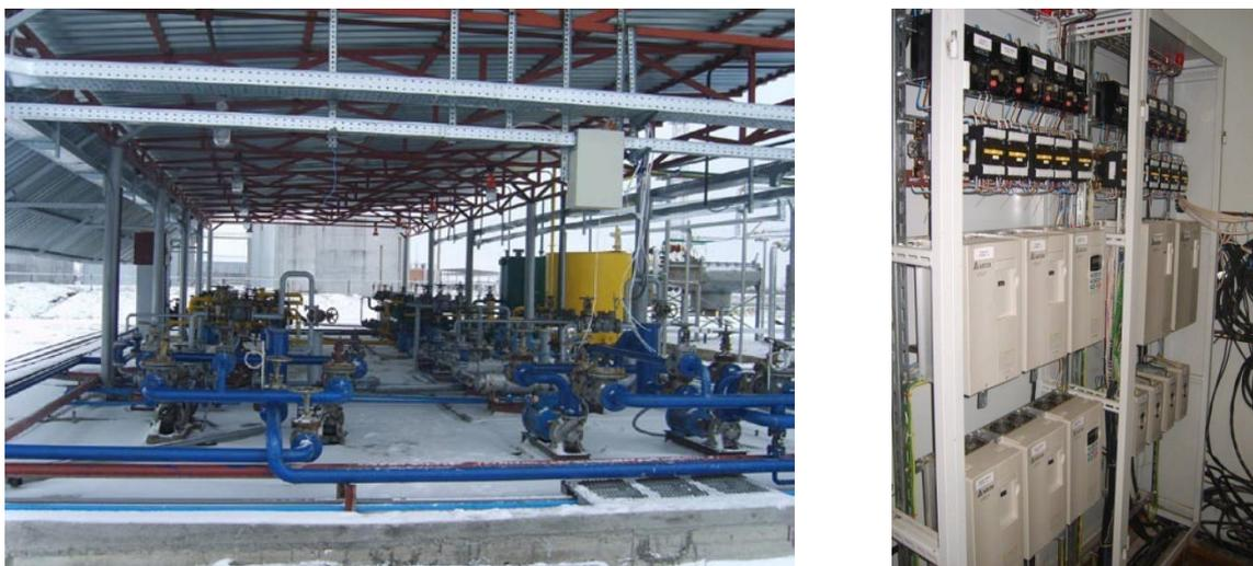
Рис. 3. Фотография насосной – слева, фотография шкафа электросилового – справа
